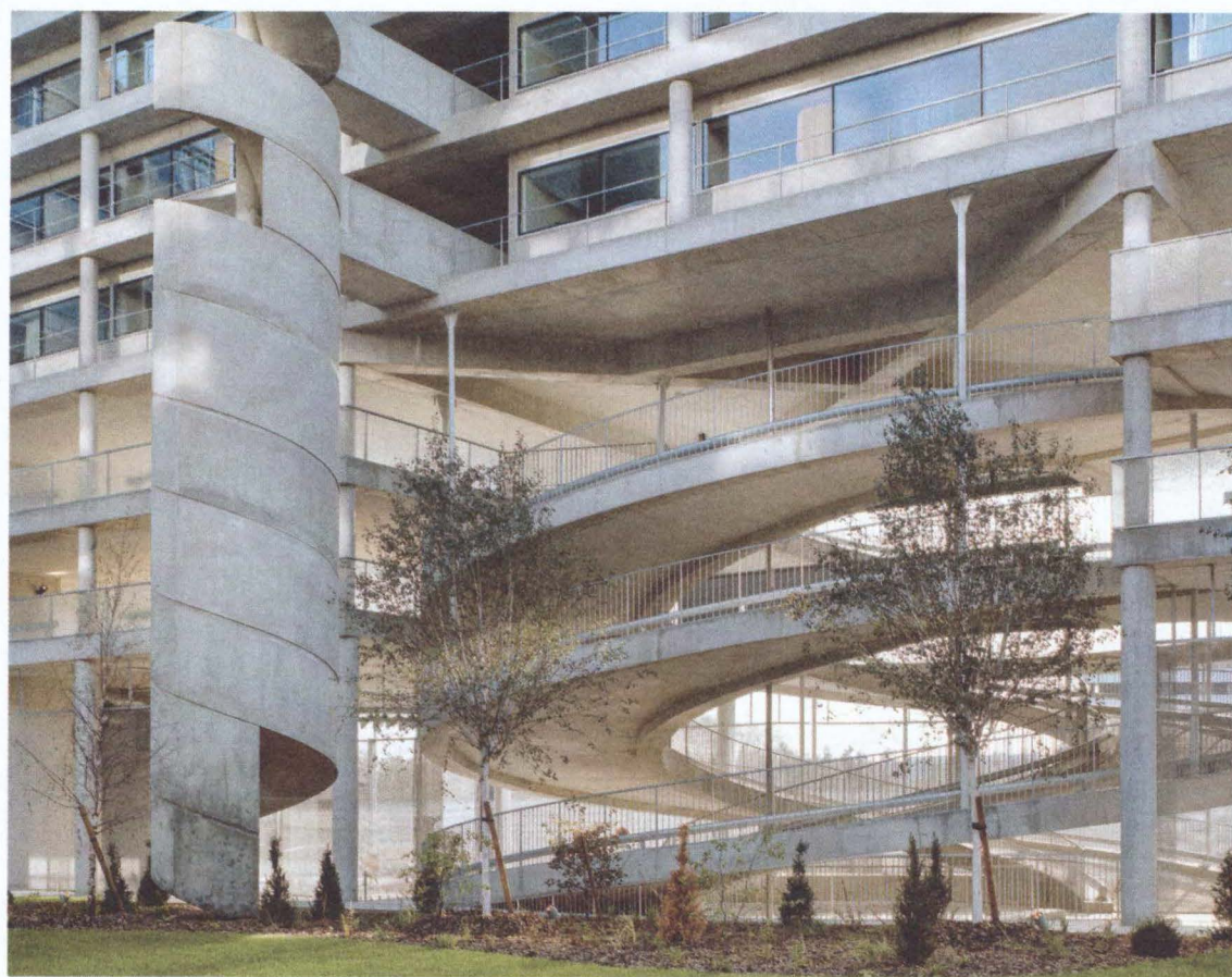
Résidence étudiante et parking réversible, plateau de Saclay à Palaiseau (Essonne), Bruther & Baukunst, architectes associés ; Logement Francilien et EPA Paris-Saclay, maîtres d'ouvrage, 2020. © Maxime Delvaux
